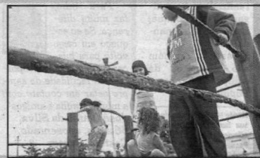
Praça Padre Donizetti (Vila Lúcia) Correntes dos balanços estão enferrujadas. A barra de segurança de uma das gangorras está solta. Algumas madeiras estão com sinais de desgaste.
