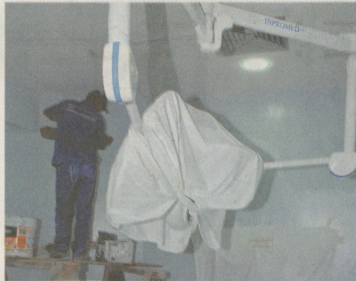
O centro cirúrgico também sofre reparos nas partes civil e elétrica
