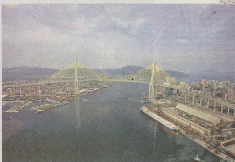
Com 2,8 Km de extensão, a ponte terá 70 metros de altura, o que permitirá a passagem de navios
