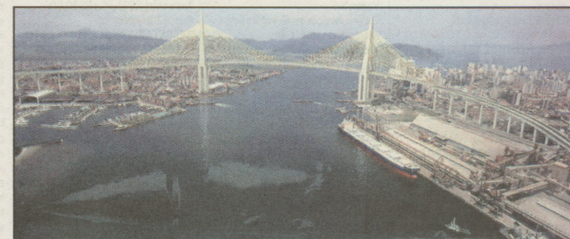
Pelo projeto, a ponte terá 2,8 km de extensão (sendo a parte estaiada com 800m), e altura máxima de 70m
